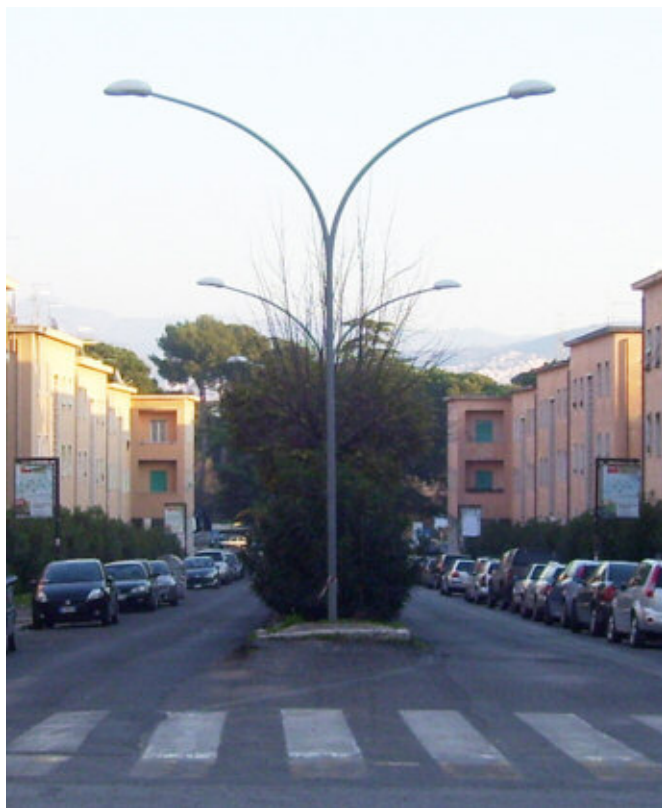
Impianto di illuminazione pubblica del comune di Guidonia Montecelio
