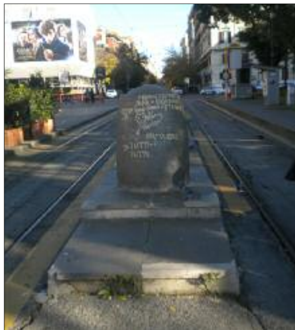
10. Un cippo sovradimensionato ostacola l'accesso al marciapiede del tram.
