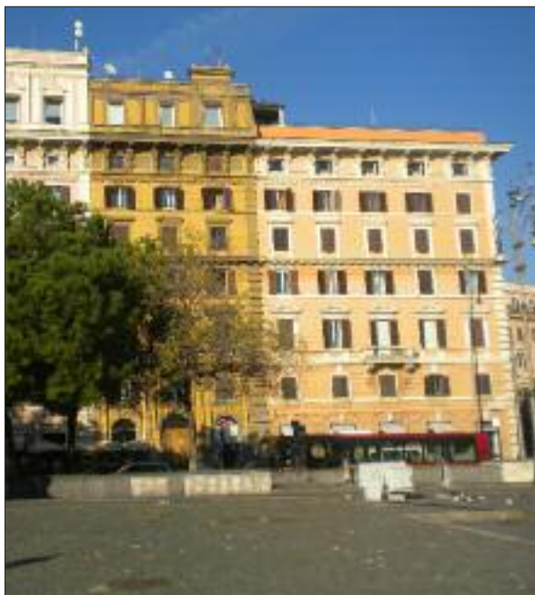
3. Edificio lato nord piazza del Risorgimento (fra via Vespasiano e via Ottaviano).
