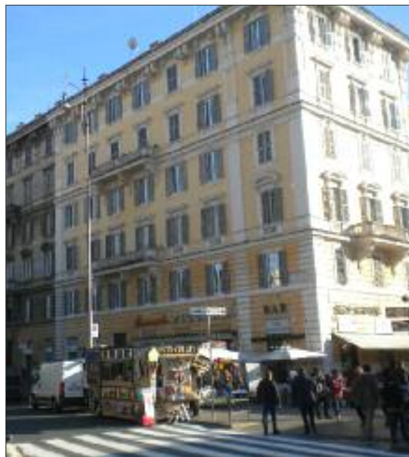
4. Edificio lato sud piazza del Risorgimento.
